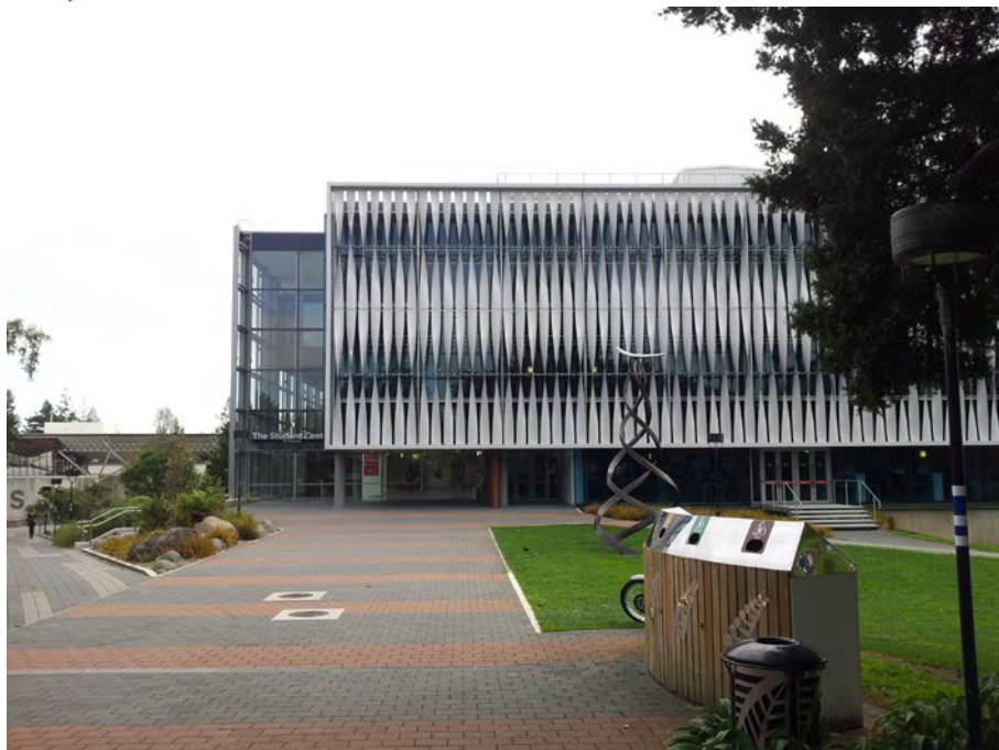
Abbildung 5: Das große Zentralgebäude mit der Bib
